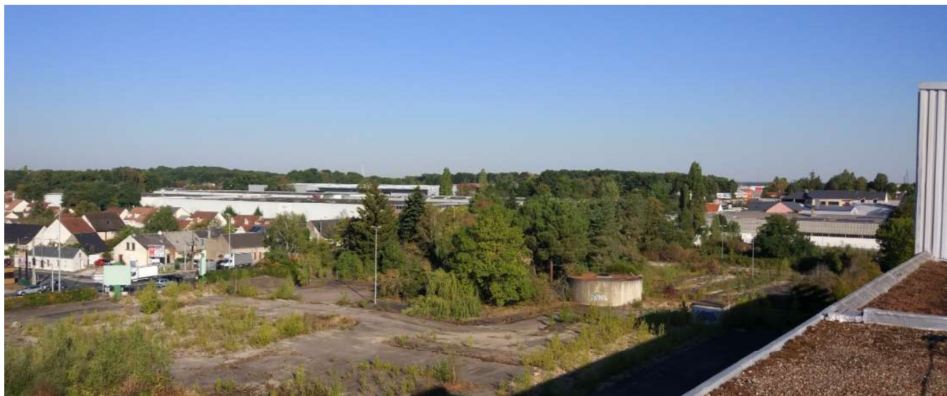
15. Vue depuis le toit du bâtiment Quelle vers le nord-ouest du site et la RD2020. Au fond le futur quartier de la Chatonnerie
