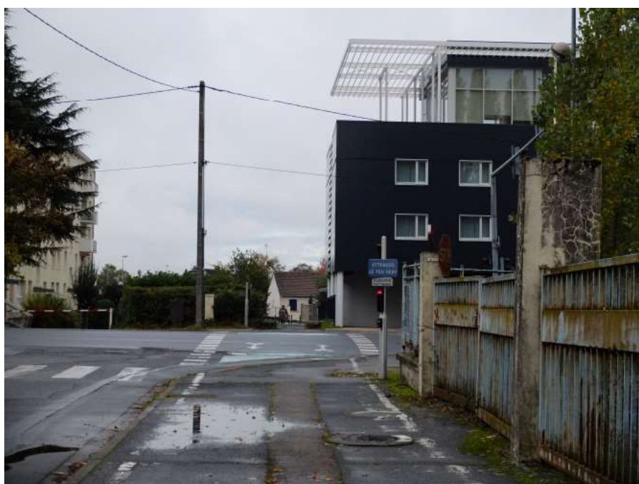
2. Vue depuis la rue de Montaran vers la RD2020. Vers les nouvelles constructions de la RD2020 (hôtel).
