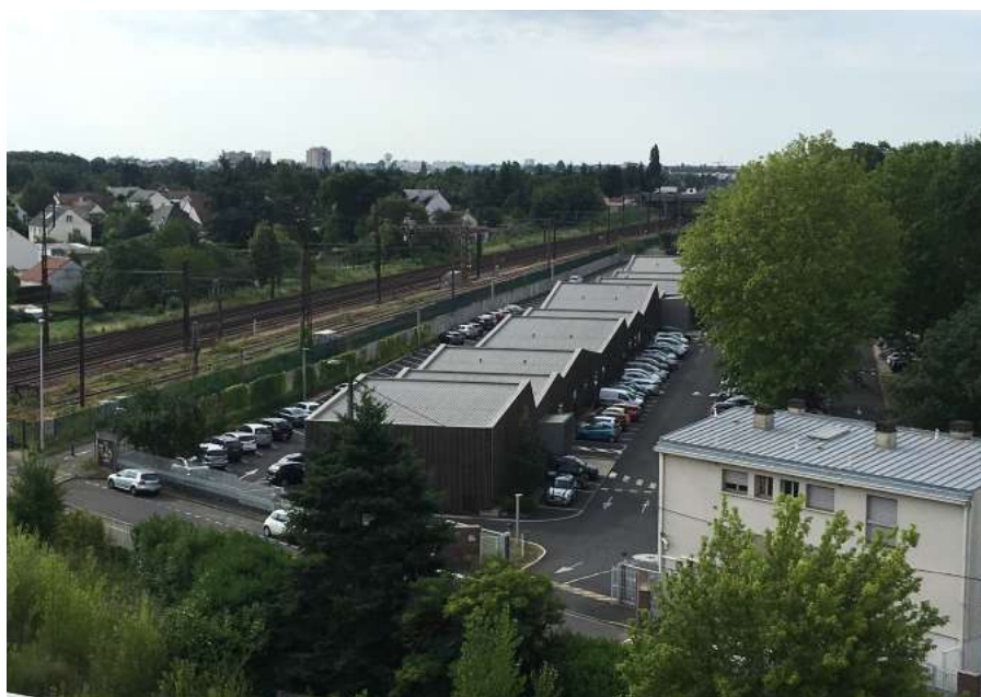
6. Vue depuis le toit de Quelle vers le sud : fin de la rue de Montaran et parcelle GMF le long de la voie ferrée.
