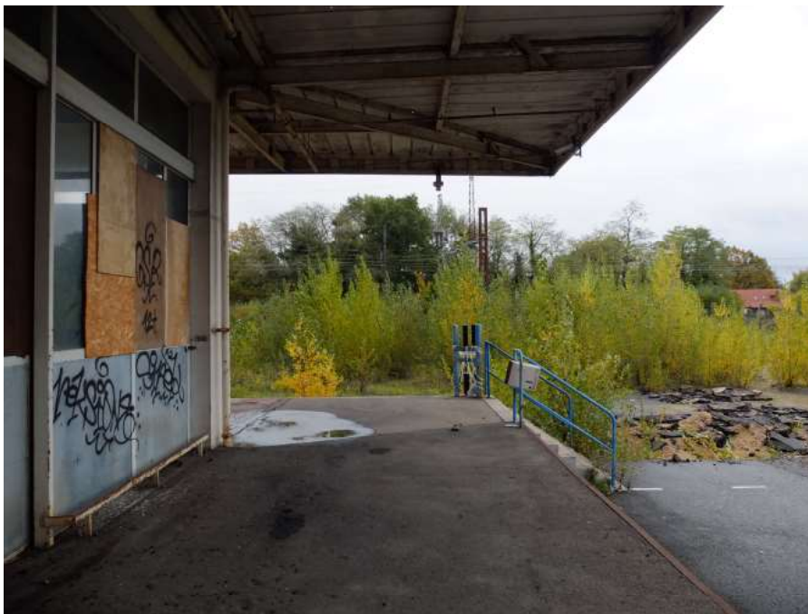
7. Vue depuis l'angle sud-est du bâtiment Quelle vers la voie-ferrée et le quartier du chêne Maillard.
