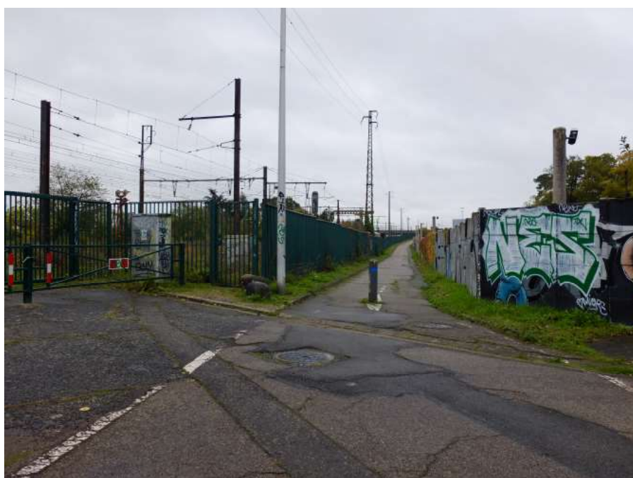
5. Vue depuis la rue de Montaran vers la fermeture de la voie ferrée et la continuité cyclable le long de la GMF.
